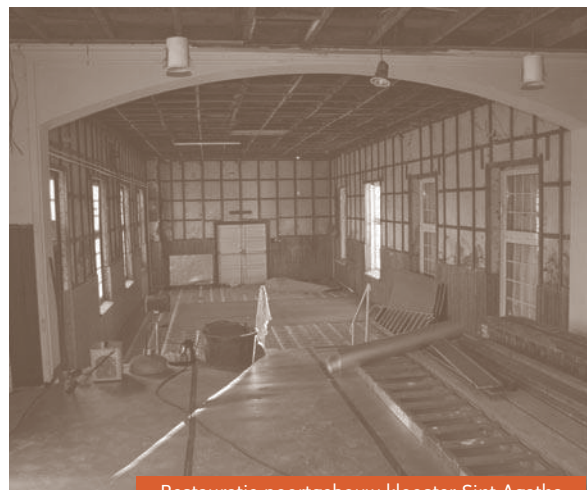
Restauratie poortgebouw klooster Sint Agatha
